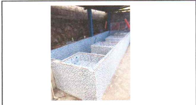
Foto 3: Pila de captación de agua reparada y sin fugas.
