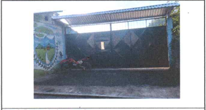
Foto 6: Porton y techo reparado.
