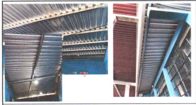
Foto 5: Techo en tres aulas reparado.
