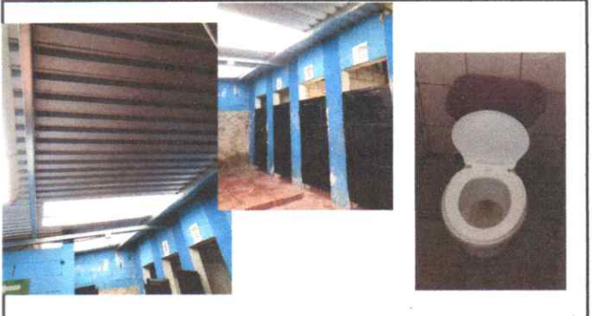
Foto 4: Techo y estructura de baños en general (sanitario, paredes pisos y puertas), remozadas.
