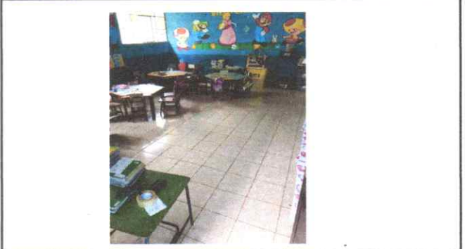
Foto 2: Piso del aula de preprimaria remozado.
